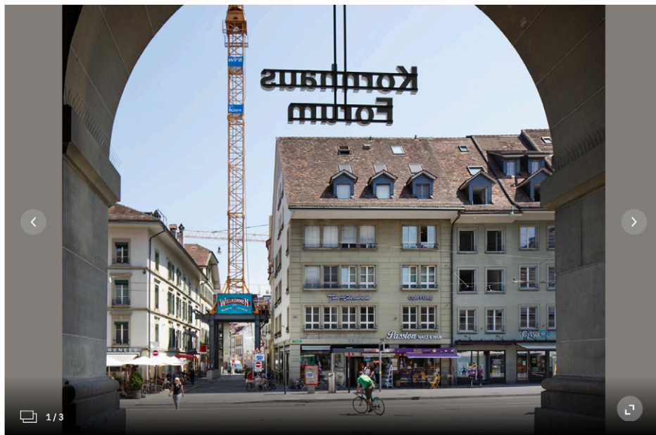
Seit Mai 2019 wird am Kornhausplatz gebaut. Die Liegenschaft, die Assetimmo gehört, ist nicht erdbebensicher. Fotos: PD
